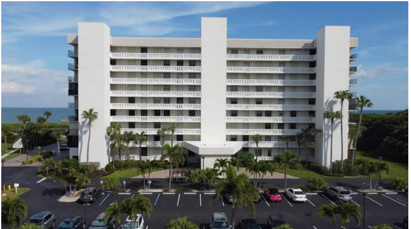
5059 N A1A (Building B) – West Elevation
